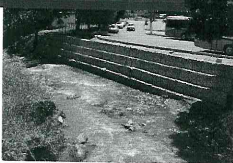
Margem do Rio Goiabeiras com Rodoviária: muro de contenção em gabião.
